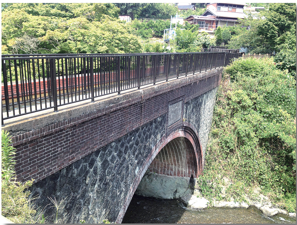
開削の際に一番苦心した工事が穴伏川の谷を渡る龍之渡井と言われています
